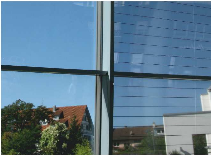
▲ Das „coole“ Sonnenschutzglas SOLARLUX®microsolar (rechte Bildhälfte) schirmt die Wärme dann ab, wenn es am nötigsten ist (im Sommer). Das eintretende Licht ist farbneutral, vergleichbar mit Wärmedämmglas (linke Bildhälfte).
